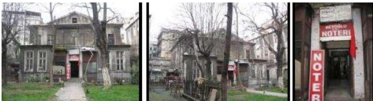
E Blok: han içerisindekiavluda inşa edilmiş bloktur. Bloğun zemin katı, han yönetimi ve Beyoğlu 2. Noteri olarak kullanılmaktaydı. Mevcutta atıl vaziyettedir. Blok; kısmi bodrum + zemin + 1 normal kat + çatı katından oluşmakta olup, atıl durumdadır.
